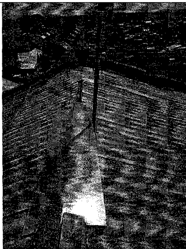
Фото 28-29. Кровля. Неполное перекрытие элементами жести конька кровли
