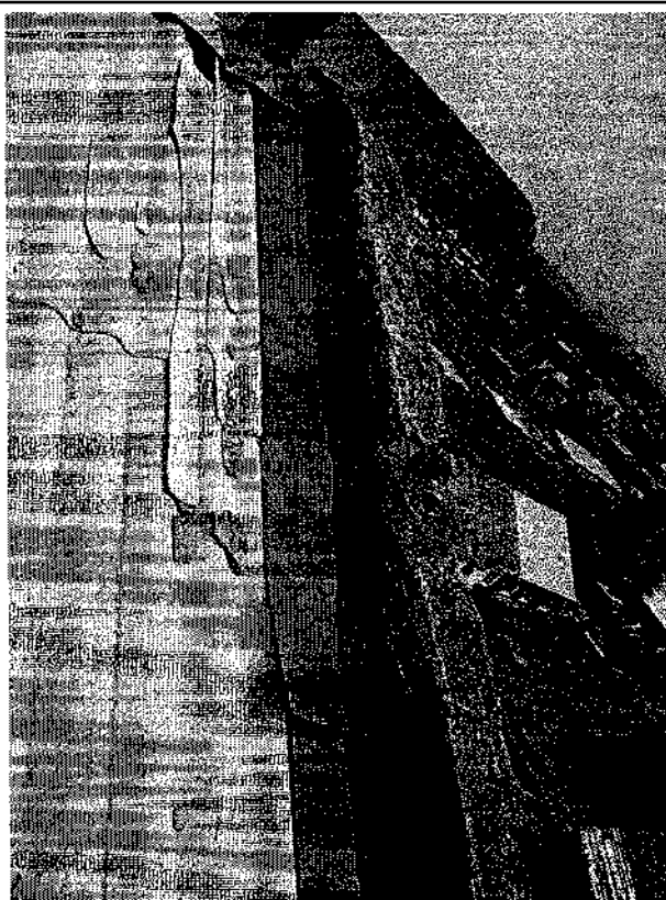
Фото 26-27. Кровля. Некачественное примыкание кровли из шифера к фронтону.
